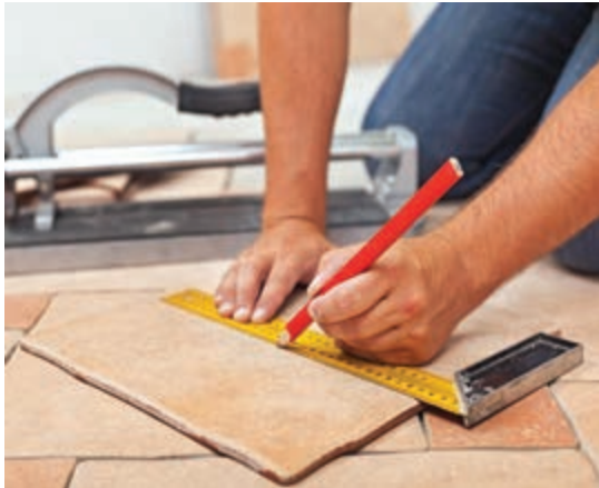
مشخص کردن مسیر برش سرامیک
