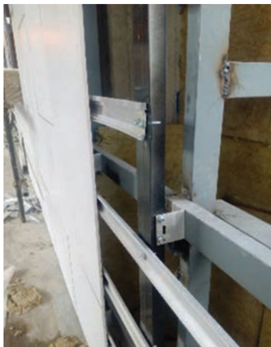
نمایی از اتصال قطعه به زیرسازی
