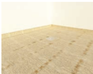
۵- تکمیل گونی لایه اول، در این مرحله کف خواب آبرو نصب می‌شود.
