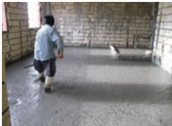
تسطیح فوم بتن قبل از خشک شدن
