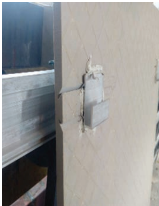
ایجاد شیار برای اتصال قطعه واسطه به پشت کاشی
