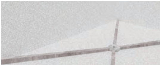
مرحله ۴- اجرای کرم‌ها
