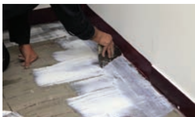
استفاده از کاردک مخصوص برای پخش کردن چسب روی سطح
