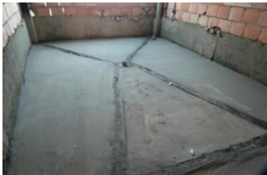
اجرای کرم و بتن شیب‌بندی حمام
