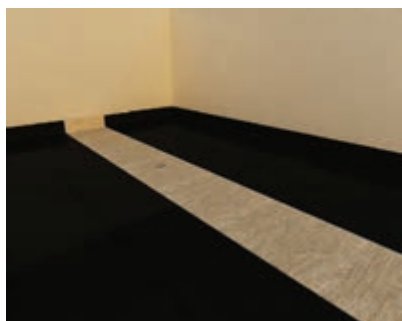
۱- آماده‌سازی کف قبل از اجرای عایق
