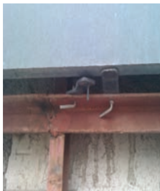
اتصال قطعات زیرسازی سنگ به دیوار
