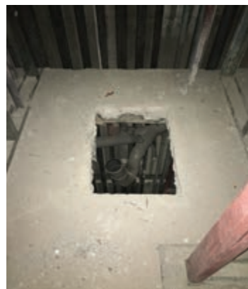
حفره جهت نصب سبد
