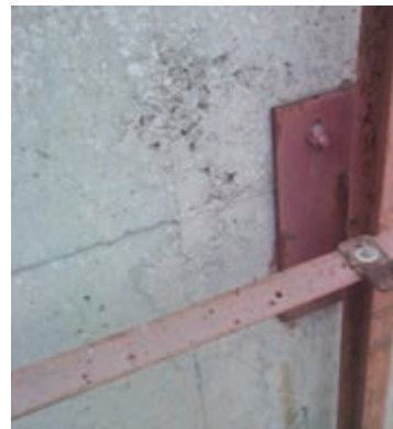
اتصال قطعات زیرسازی سنگ به دیوار
