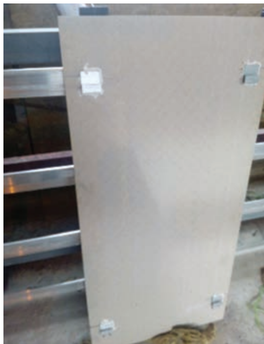
ایجاد شیار برای اتصال قطعه واسطه به پشت کاشی
