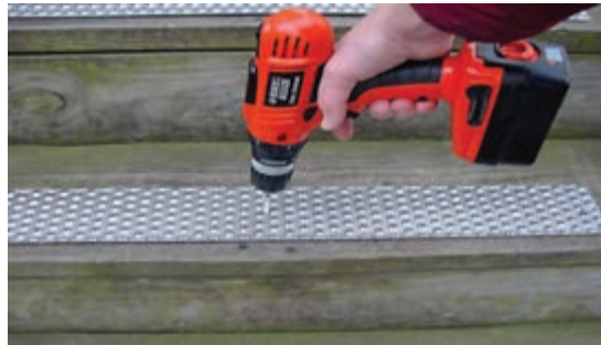
ورقه‌های آلومینیومی مانع از سر خوردن از روی سطح سنگ می‌شود.
