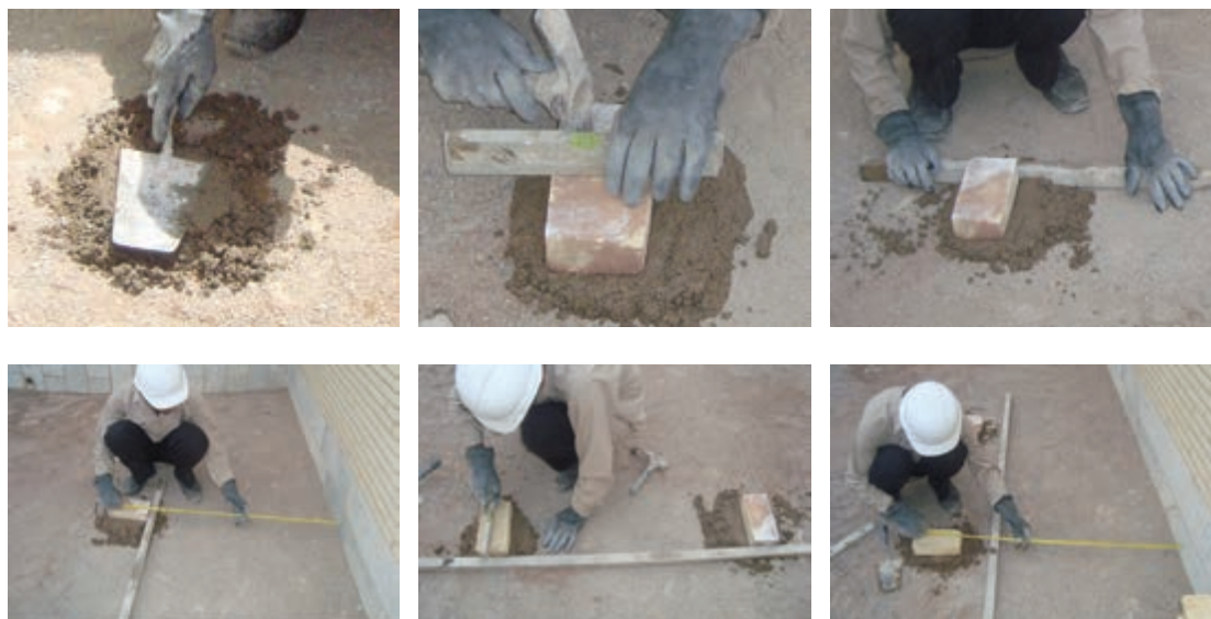
مراحل تعیین محل جداکننده
