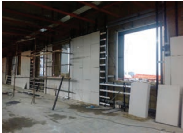
اجرای زیرسازی فلزی
