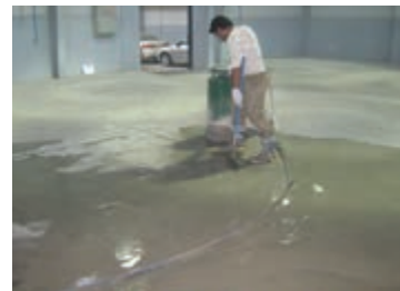
اجرای ملات برای مسطح کردن سطح
