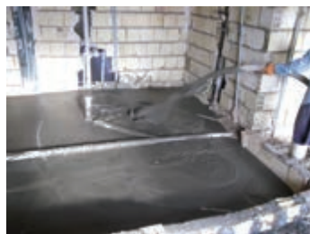
اجرای فوم بتن به عنوان بتن کف‌سازی
