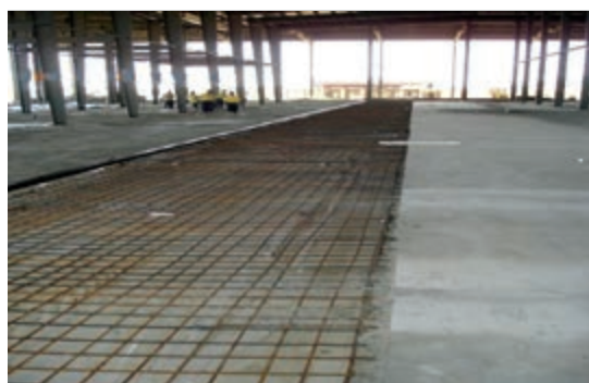
اجرای بتن کف
